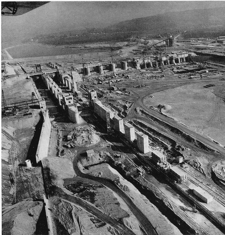
Österreich baut durch eine Kraftwerkskette die Donau zur Großschiffahrtsstraße für den ganzjährigen Verkehr mit dem Europakahn aus. Auf unserem Bild das im Bau befindliche Kraftwerk Ottensheim-Wilhering, das 1973 in Betrieb genommen wird. Der Schleusenbetrieb wird bereits im Herbst des heurigen Jahres aufgenommen. Die Donau wird in ein neues Flußbett umgeleitet.
